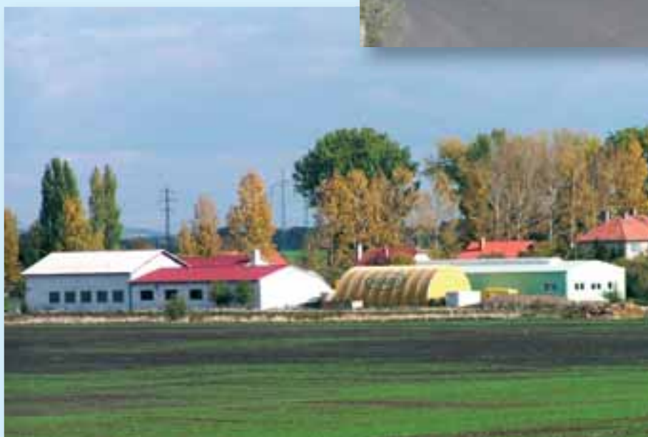
Výrobní závod Klaro - Velké Chvalovice / Factory building - Velké Chvalovice
